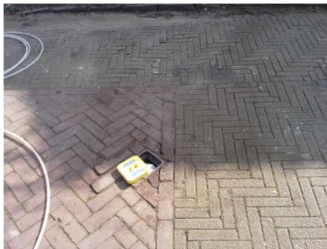
Figuur 8: Afwerking peilbuizen 1003A en 1004A
